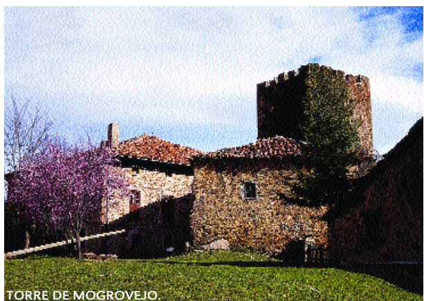
TORRE DE MOGROVEJO.
